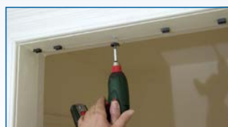
Fissaggio delle clip (comprese nel volume di fornitura della porta a soffietto).
